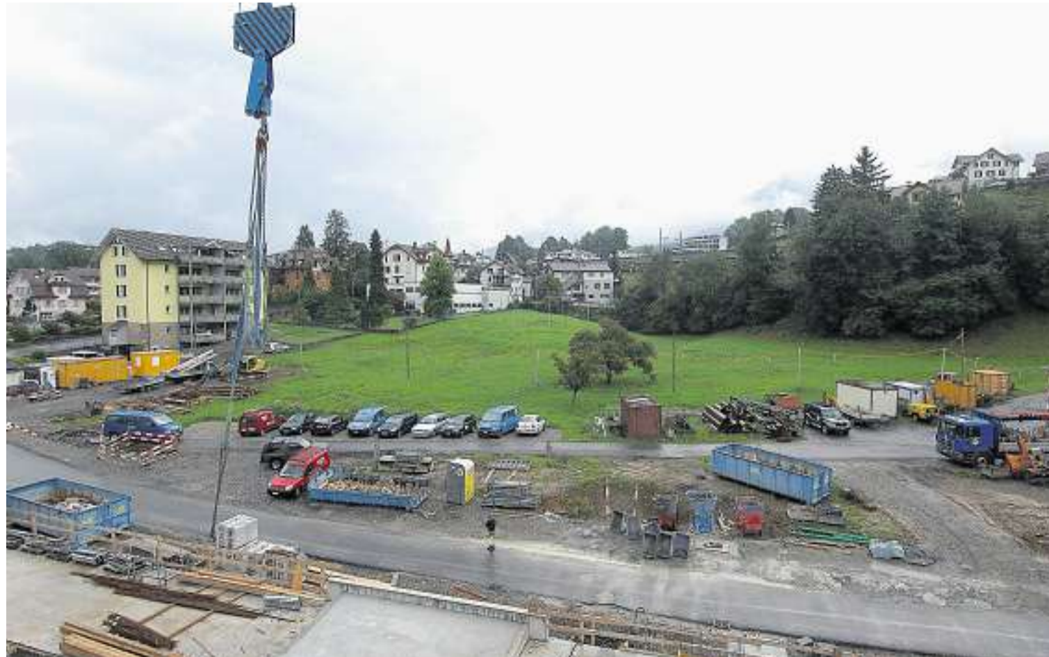
Blick von einer der bereits erstellten Rohbauten: Von der dritten Ausbautetappe ist erst ein Baugespann zu sehen. Die sechs Mehrfamilienhäuser kommen auf der nun noch leer stehenden Fläche zu stehen. Bild Andreas Seeholzer
